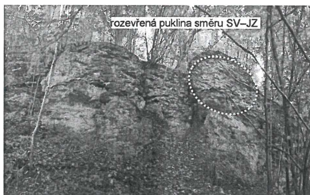
Foto 14 Západní část prvního stupně geomorfologického patra bezprostředně přiléhajícího k cyklostezce. Červená tečkovaná elipsa vlevo naznačuje partii k odtěžení (Klinčůch – Holý 2018). Skalní útvar ve žluté tečkované elipse upravo bude stabilizován kotvením přes rozevřenou puklinu, jak naznačuje fialová šipka .
